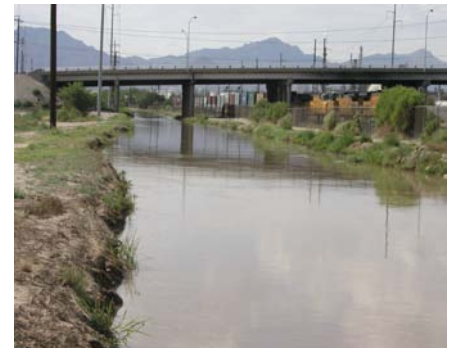
Unlined Franklin Canal above Ascarate Lake, El Paso, TX
